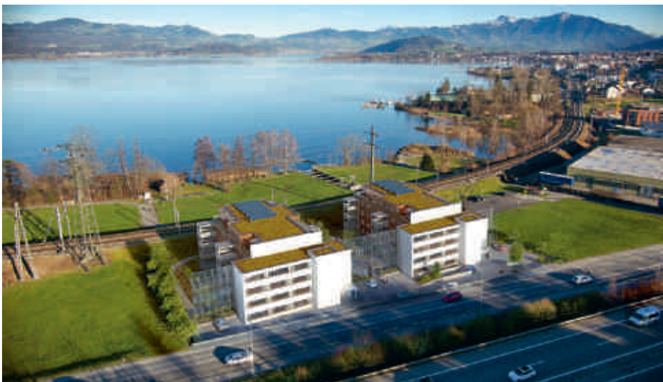
Strassenlärm auf der einen – atemberaubende Seesicht auf der anderen Seite. Die Lösung: Büro- und Gewerbetrakt als Schallschutzgürtel zum Wohnbereich hin.
