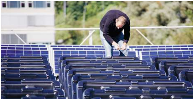
Platzierung der Module auf dem Dach
